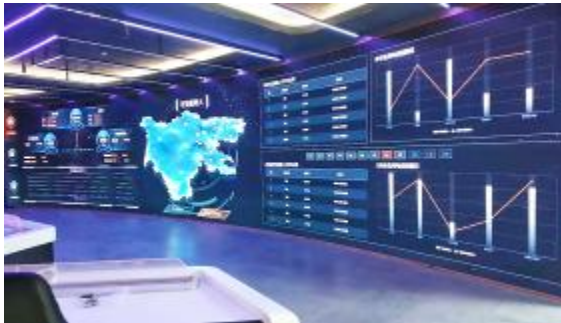
国家电网四川省电力公司
